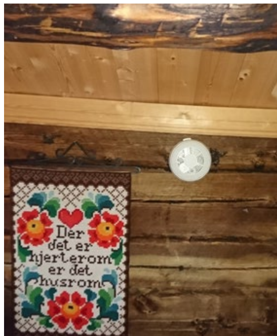
Under hyttefeiing har vi funnet en del avvik. Bildet til venstre: For liten avstand til brennbart materiale. Bildet til høyre: Røykvarslere skal plasseres i taket, minimum 50 cm fra veggen.
