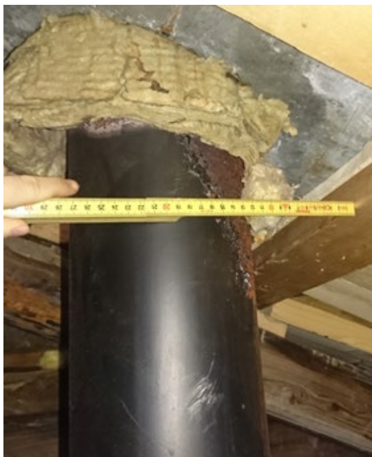
Under hyttefeiing har vi funnet en del avvik. Bildet til venstre: For liten avstand til brennbart materiale. Bildet til høyre: Røykvarslere skal plasseres i taket, minimum 50 cm fra veggen.
