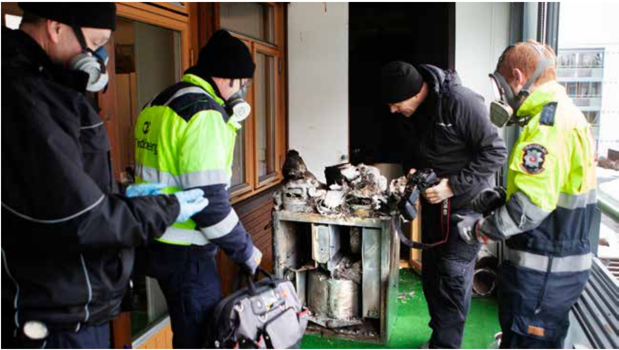
ETTERFORSKNING: 19 branner ble etterforsket av etterforskningsgruppen fra TBRT, politiet og Det lokale eltilsyn. Funn fra denne etterforskningen gjorde at det ble vedtatt bruksforbud på ventilasjonsanlegget i 481 leiligheter.
